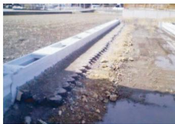
岐阜県 可変側溝B300×H600
