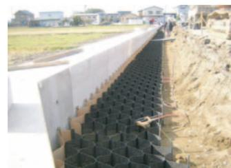
三重県 可変側溝B500×H800
