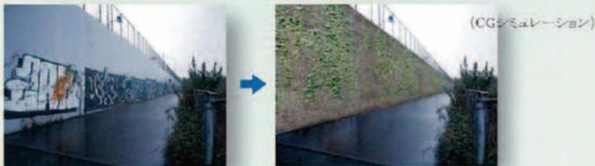
ビオマークの多孔質構造の特徴を生かしたツタ植物を使用した壁面緑化の提案
