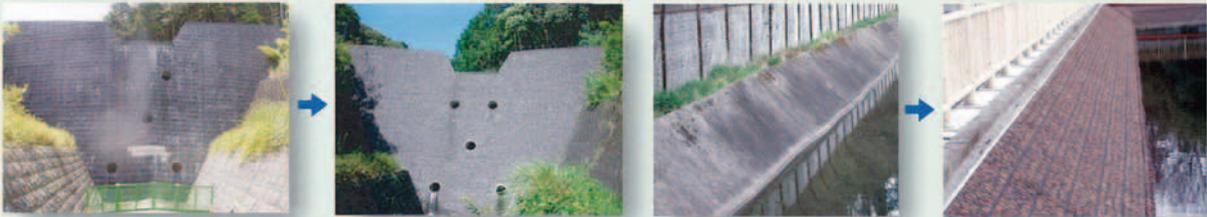
**2. 生態系の保全 :** ・両生爬虫類、昆虫類などの小動物の移動を阻害するコンクリート構造物を移動可能な多孔質環境に回復する(分断されたビオトープネットワークの回復)
