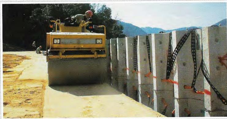
〔重機による壁面近傍の転圧状況〕
