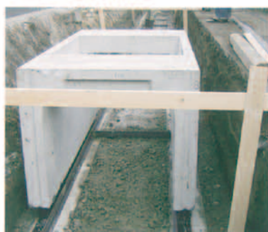
三重県 自由勾配側溝 B800×H700×L2000 W=1,270kg 人力施工
