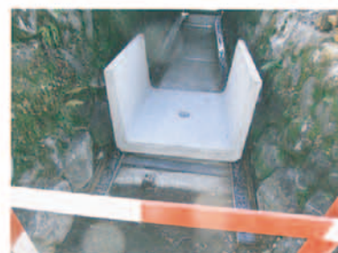
岐阜県 ベンチフリューム1種 900×L1000 W=379kg 人力施工
