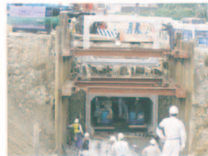
2台のミニバックホウでの施工 既設カルバートで待機
