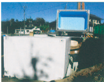
大分県 耐震性防火水槽40m 3 4ピース maxB3200×H2000×L1600 W=10,830kg
