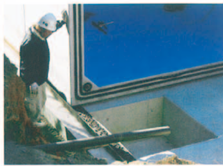
大分県 耐震性防火水槽40m 3 4ピース maxB3200×H2000×L1600 W=10,830kg
