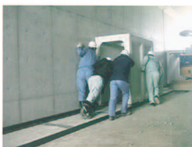
三重県 自由勾配側溝 B700×H1600×L2000 W=1,790kg 人力・機械併用施工
