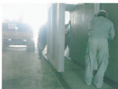
三重県 自由勾配側溝 B700×H1600×L2000 W=1,790kg 人力・機械併用施工
