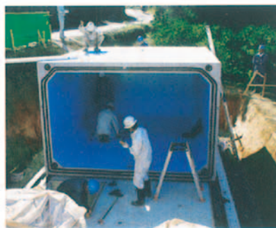
大分県 耐震性防火水槽40m 3 4ピース maxB3200×H2000×L1600 W=10,830kg
