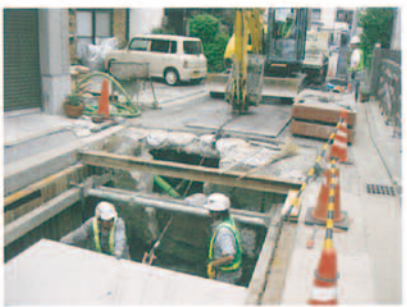
愛知県 ボックスカルバート B2000×H800×L2000 W=5,860kg バックホウで引張施工
