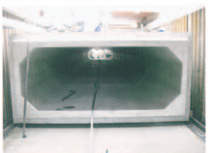
愛知県 ボックスカルバート B2000×H800×L2000 W=5,860kg バックホウで引張施工
