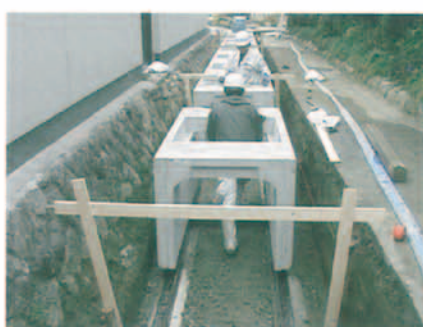
三重県 自由勾配側溝 B800×H700×L2000 W=1,270kg 人力施工
