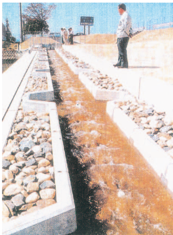
ほぼ完成した芦田川河口堰右岸の魚道
