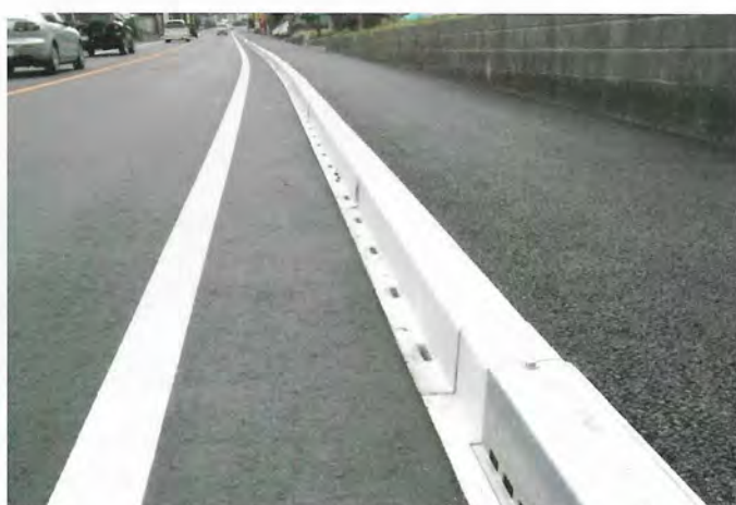
排水型歩車道境界ブロックの施工例
