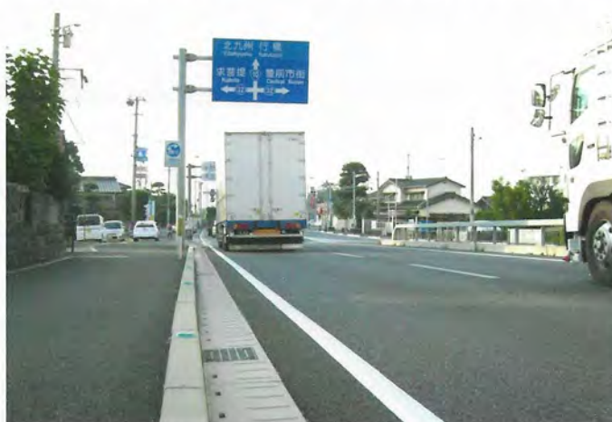
雑草の成長が殆んど確認できない暗渠形側溝と組み合わせて施工された歩車道境界ブロック
