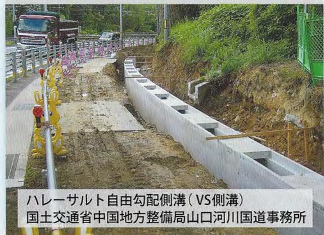
ハレーサルト自由勾配側溝(VS側溝)
