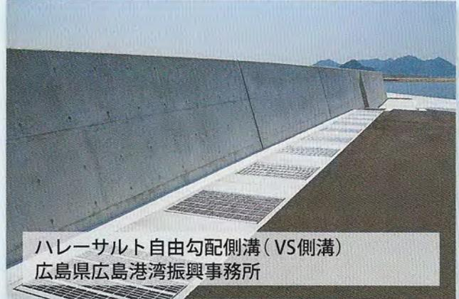
ハレーサルト自由勾配側溝(VS側溝)
