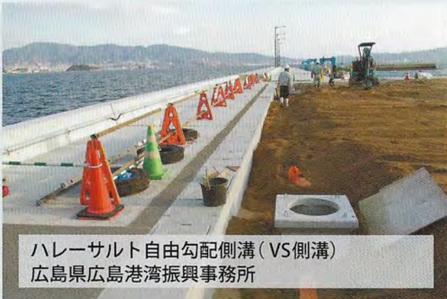
ハレーサルト自由勾配側溝(VS側溝)
