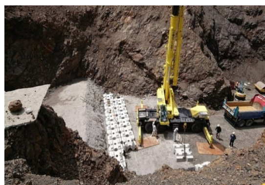
1段目設置状況
