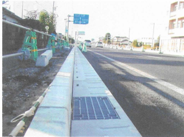
● 暗渠型側溝の施工例 (福岡県)
