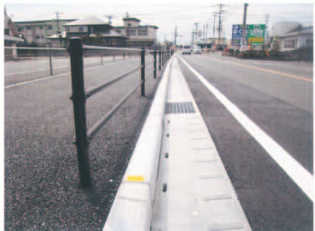
● 円形型スリット付側溝の施工断面例
