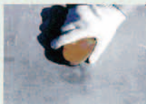
施工面の清掃
