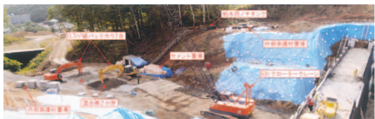
施工ヤード事例
