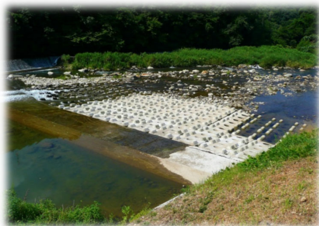
三篠川(青頭首工)
