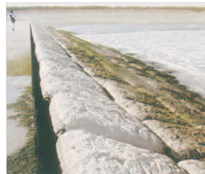
千葉県長生土木事務所 「一松海岸」 2ton(脚付タイプ)
