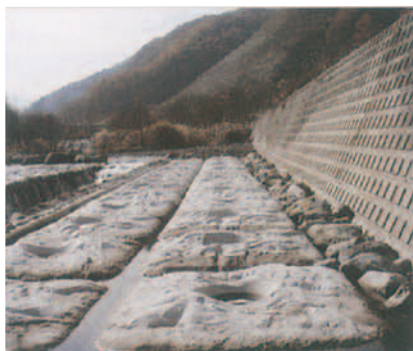
関東地方整備局 富士川砂防工事事務所 「釜無川・広岩床固魚道設置工事」 5ton(脚付タイプ 有孔)
