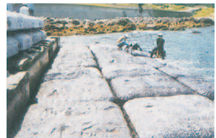
北海道 函館土木現業所 4ton(基本タイプ) 「恵山岬道単局改良工事」
