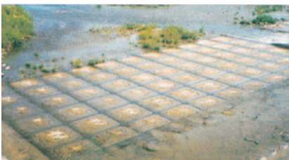
長崎県 諫早土木事務所 2ton(基本タイプ) 「萱瀬ダム水位観測用帯工設置工事」
