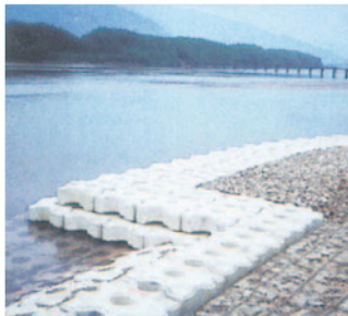
四国地方整備局 徳島工事事務所 「吉野川」根固工
