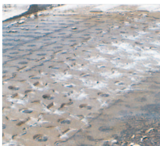
新潟県 小千谷土木事務所 「田河川」落差工
