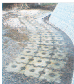
島根県 益田土木建築事務所 「益田川」根固工
