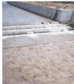
福島県 県北建設事務所 「石田川」護床工
