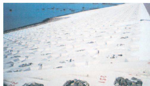
長崎県 島原振興局 「西郷海岸」緩傾斜護岸(4割勾配)
